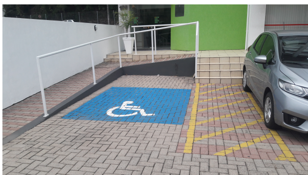
Figura 1: Sinalização horizontal no edifício nº 100
