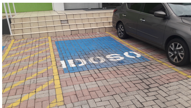
Figura 2: Sinalização horizontal no edifício nº 100
