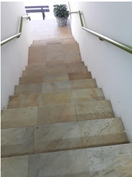
Escada da entrada – acesso da portaria
