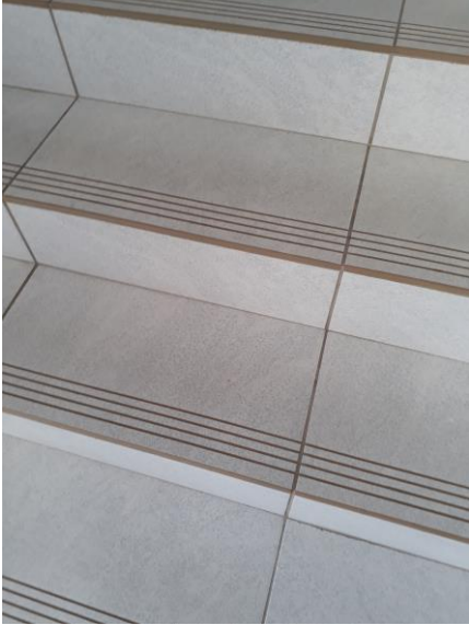
Escadas do meio – acesso as salas de aula
